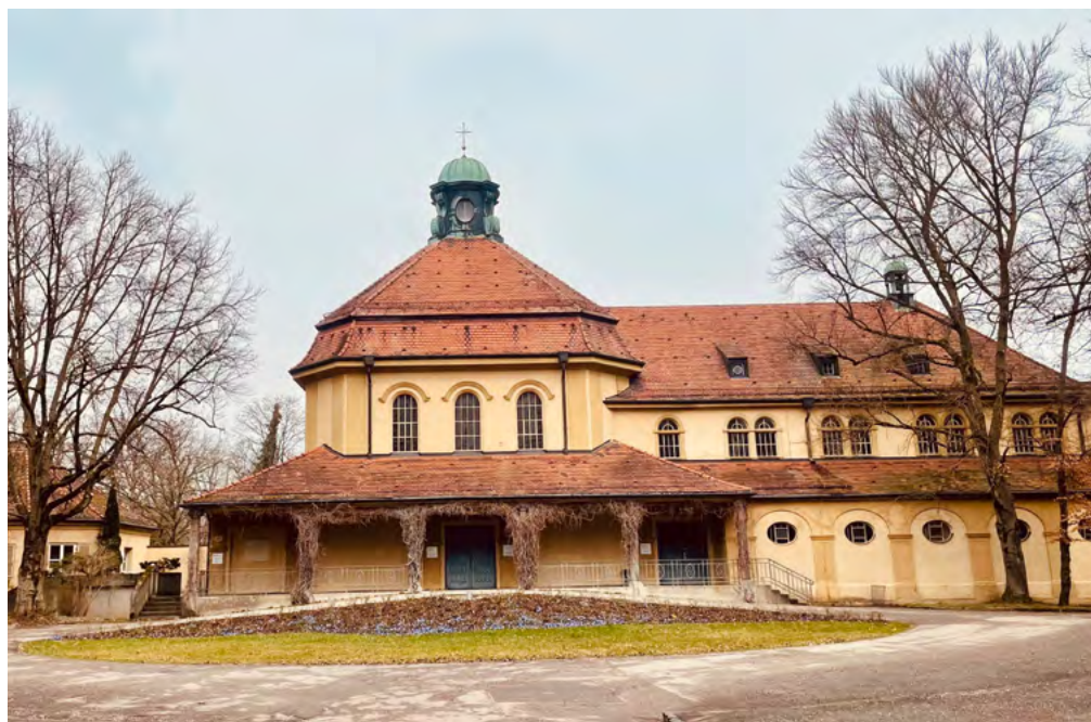
Das Krematorium am Augsburger Westfriedhof: Die Anlage von 2008 befindet sich im denkmalgeschützten Gebäude von 1912.
