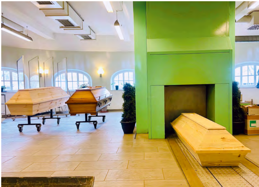
Der Krematoriumsofen im Augsburger Westfriedhof: Bevor der Sarg automatisch in die Brennkammer fährt, wird er geöffnet und geprüft.
